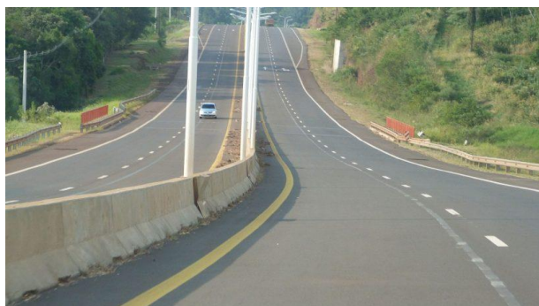
Figura 2. Traza de la Ruta Nacional N° 12 convertida en autopista en el año 2018. Tramo Cerro Corá-Santa Ana. La defensa longitudinal tipo “New Jersey” que separa los sentidos de circulación en la carretera representa una barrera para el cruce de la fauna autóctona.
