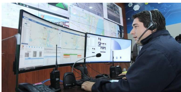
Figura 21. Ejemplo de Centro de Monitoreo, similar a instalar en la DNV.
